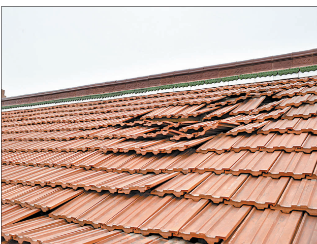
这是1月23日拍摄的灯塔市柳条寨镇树碑台村在地震中受损的屋顶(新华社发)
