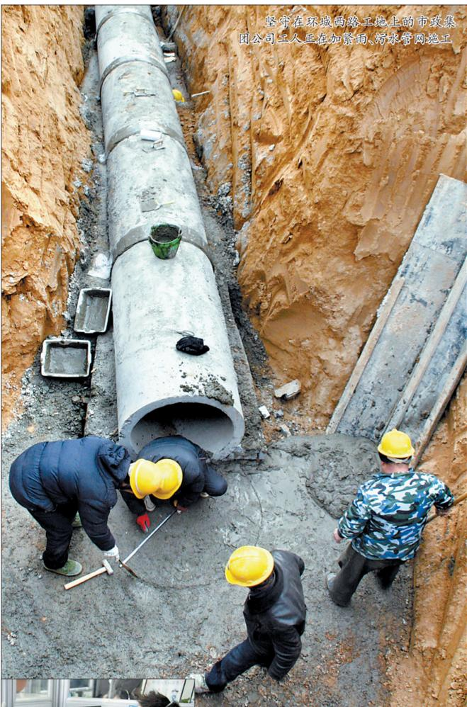
坚守在环城西路工地上的市政集团工人正在加紧雨、污水管网施工
