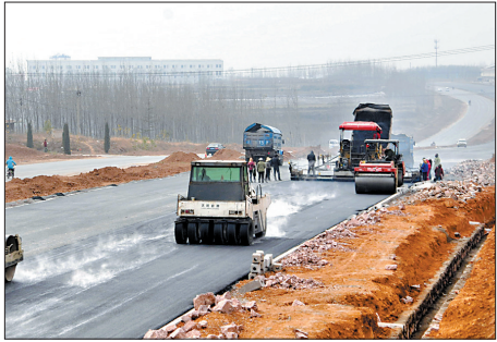
正在扩宽的小浪底大道
