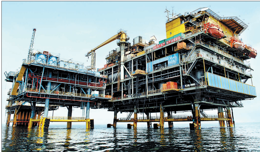
中海油经中36-1油田中心平台 新华社记者杨青摄
