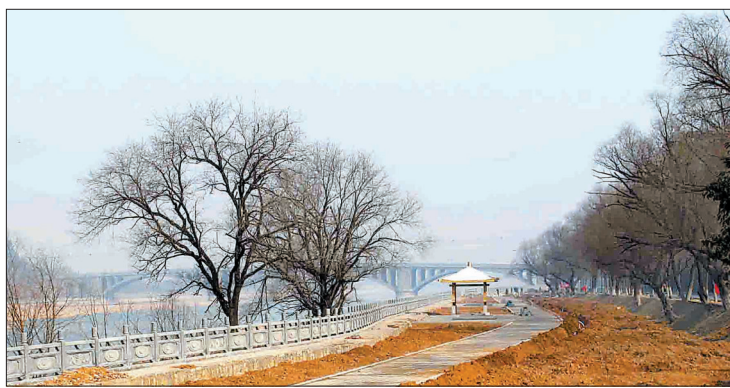
伊东渠改造工程现场
