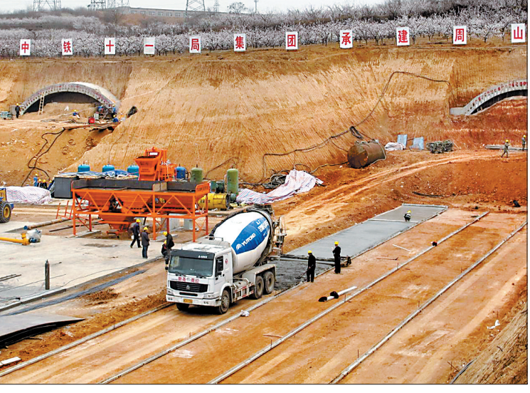
图为周山隧道施工现场 见习记者 孙小蕊 摄
