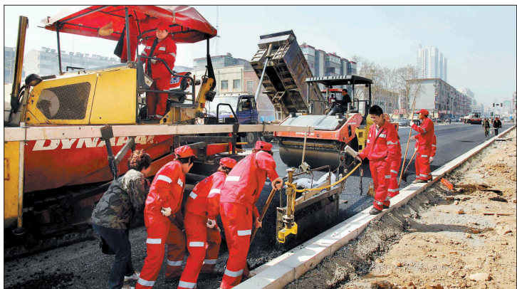
施工人员在丽春东路摊铺沥青 记者 何浩 摄
