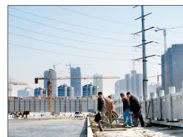
施工人员在铺设唐宫西路跨涧河桥人行道 记者 李东慧 摄
