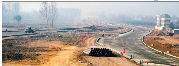
东环路一期工程正在加快推进 记者 李东慧 摄
