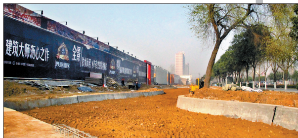
开元大道东段水系工程已完成基础施工 记者 李东慧 摄
