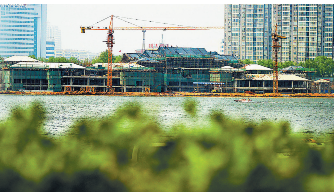
位于洛河北岸、洛阳桥东橡胶坝处的茶苑项目施工现场
