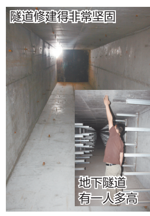
隧道修建得非常坚固
