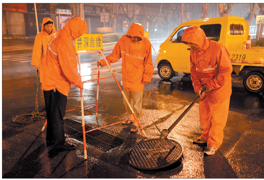
养护工人打开雨水检查井井盖
