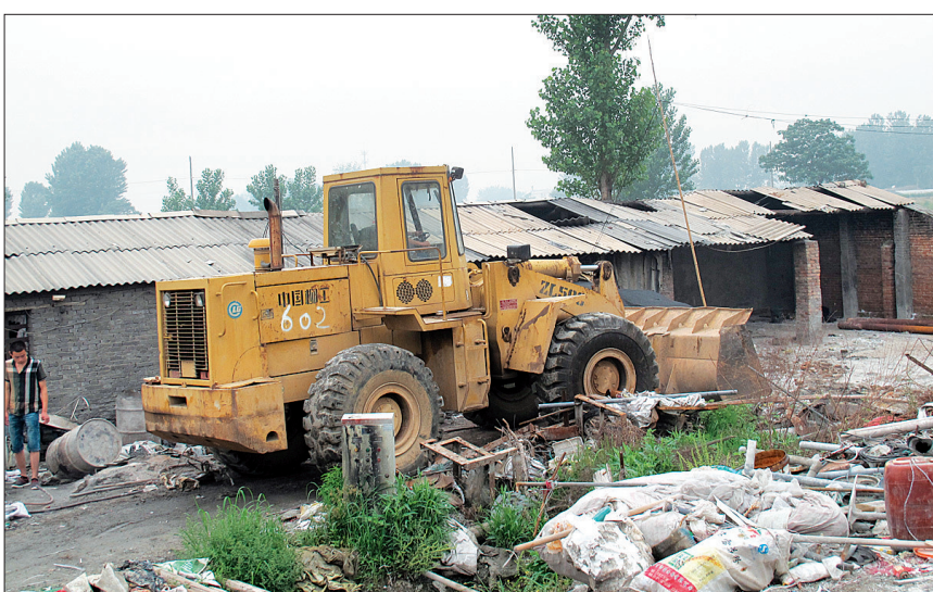
大型机械正在拆除作坊设施 记者 王子君 摄
