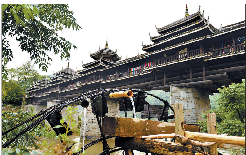
侗族木制建筑艺术的杰出代表——程阳风雨桥
