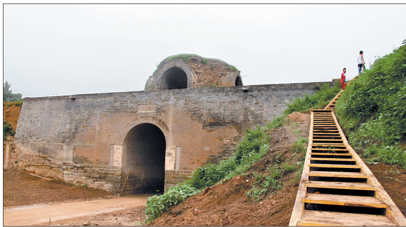
通过新铺的木栈道，可登上关楼
