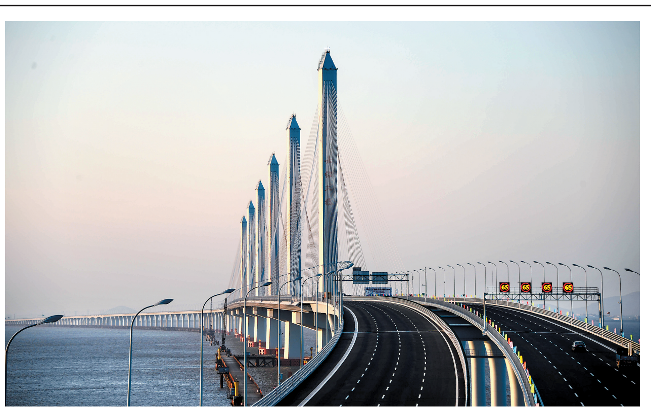
世界上最长最宽的多塔斜拉桥——嘉绍跨海大桥明日通车
