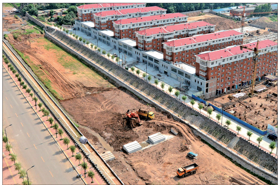
西小河综合治理施工现场
