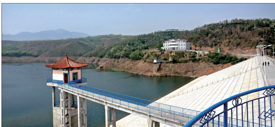
赵保镇寺河水库除险加固工程
