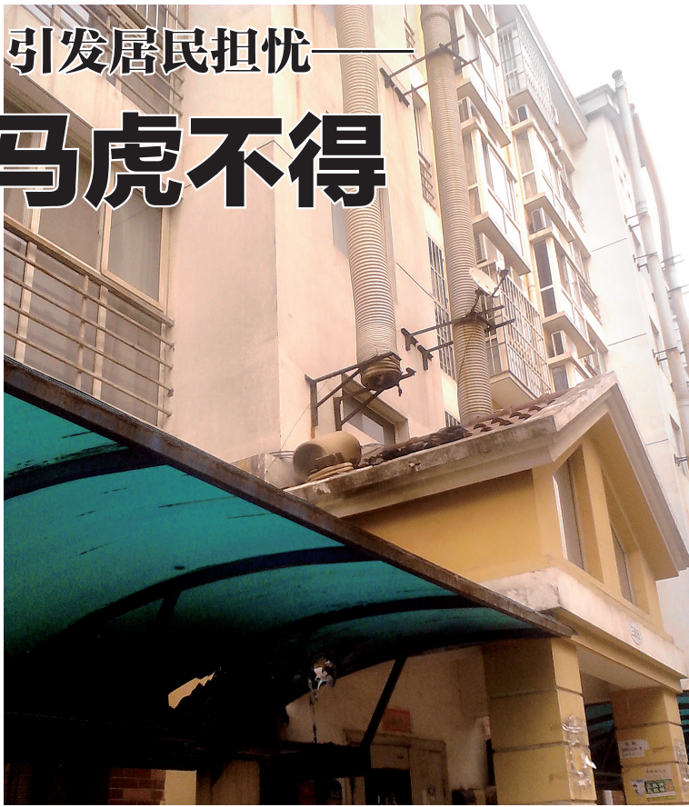
事发小区居民楼旁的排烟管道
