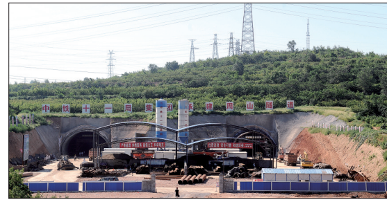
西环路周山隧道加快施工
