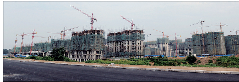
正在崛起的泰和家苑社区楼群
