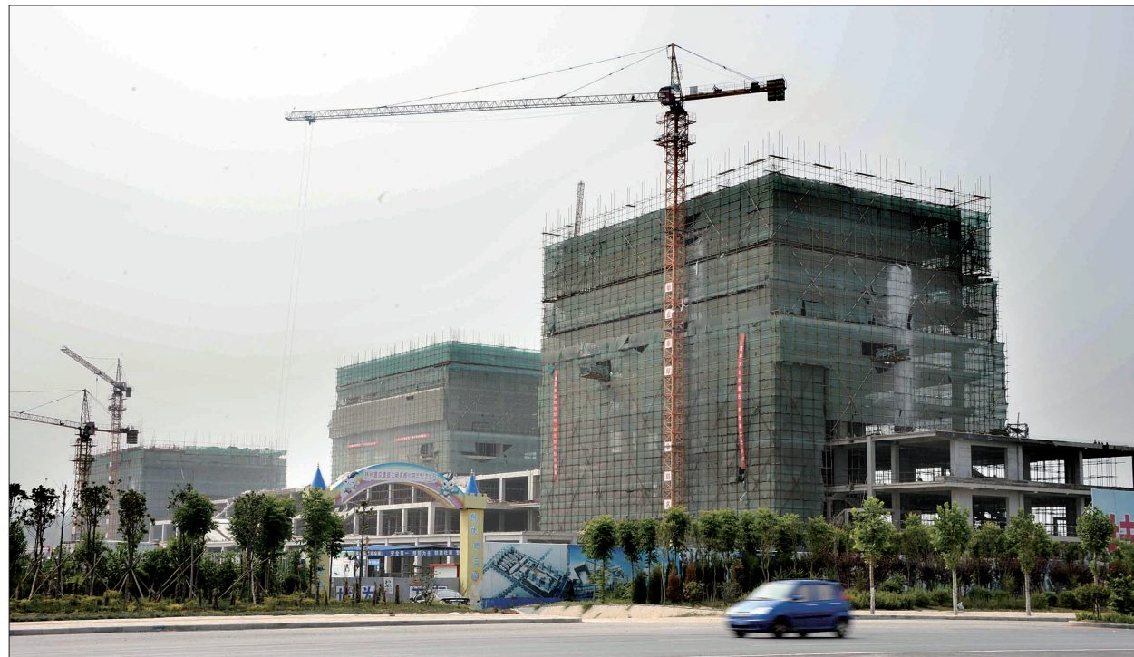
建设中的中国动漫之都产业园项目 记者 梅占国 摄
