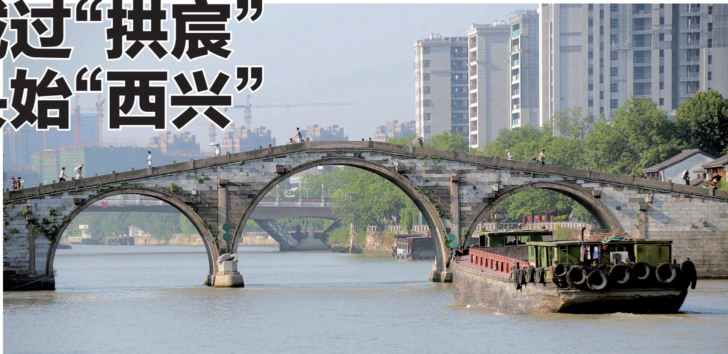
位于京杭大运河杭州城区段的拱宸桥
