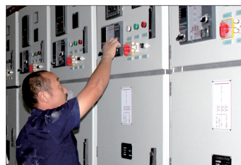
安装调试设备
