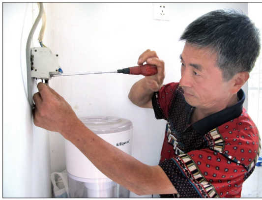
徐琦在修理社区活动室的空调开关
