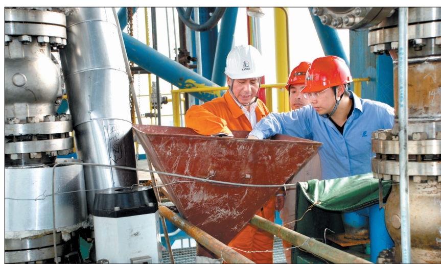
技术人员在我国首套百万吨级工业示范装置现场进行催化剂装填检查
