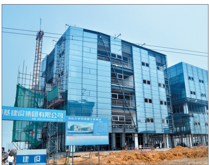
洛阳·大学科技园孵化区主体工程基本完工
