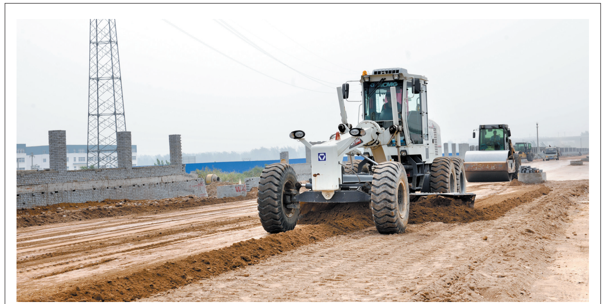
新华东路加紧施工 近日,今年4月底开工建设的新华东路正在加紧施工...
