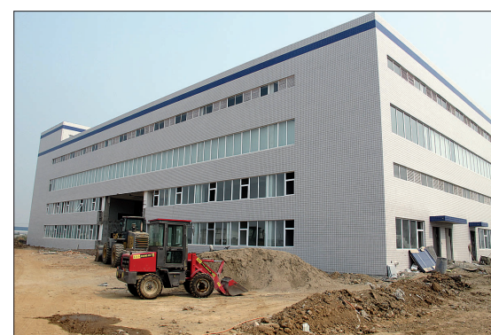
建设中的项目制疫苗厂房
