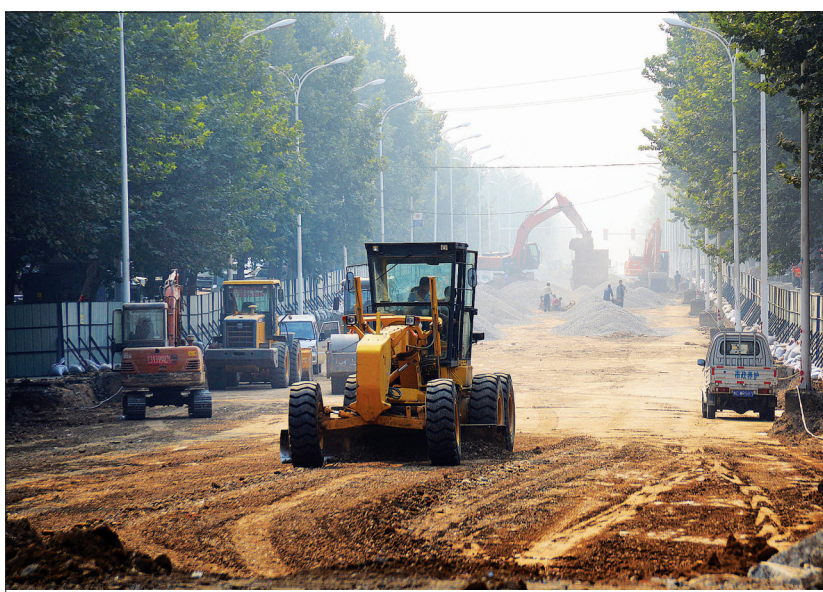
十一长假期间,在九都路改造工程施工工地上,施工人员忙个不停,各种大型机械昼夜不间断作业。目前,部分路段开始铺设混凝土垫层,改造工程进展顺利。 记者 常书香 刘冰 摄影报道
