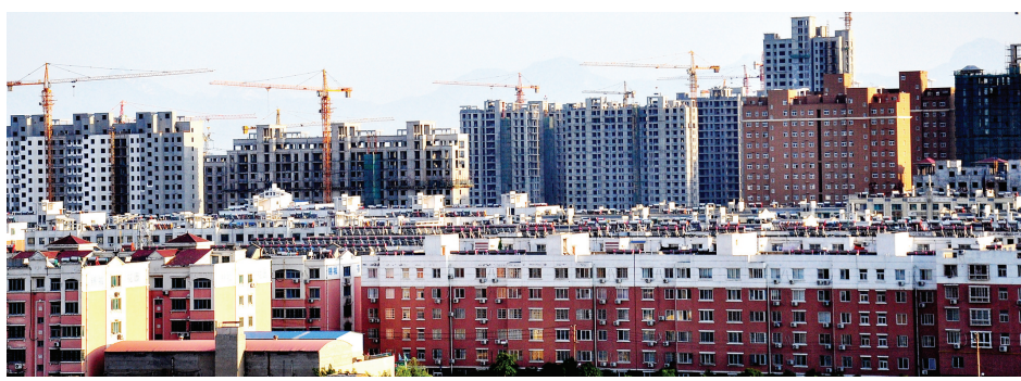
热火朝天的镇区建设场面
