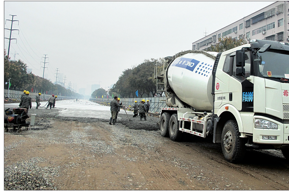
九都路改造提升工程施工现场
