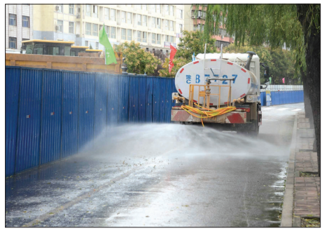
给道路两侧通道路面洒水防尘
