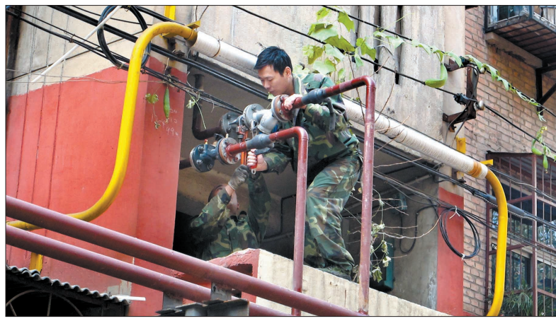
施工人员在洛轴15号生活区内进行管网铺设工作
