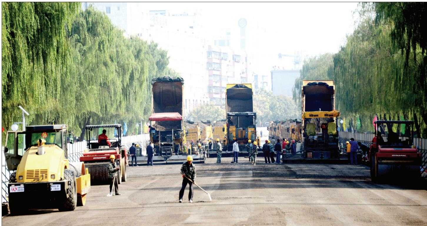
河南力大公司采用三机联合施工法鏖战九都路改造提升工程
