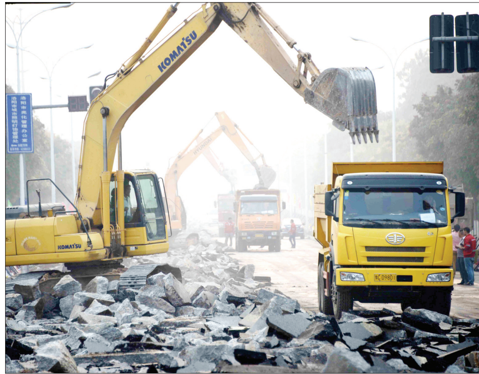
河南力大公司会战九都路改造提升工程
