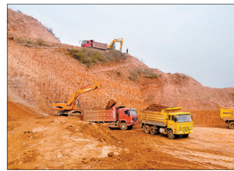
挖方路段,大型机械在紧张地作业 袁喜宝 摄
