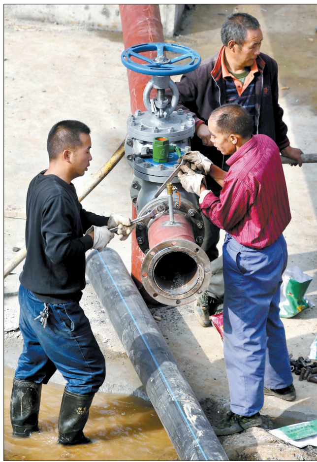
施工人员在栾川乡后坪村建渗水井,缓解县城居民用水难
