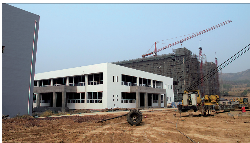
项目建设现场
