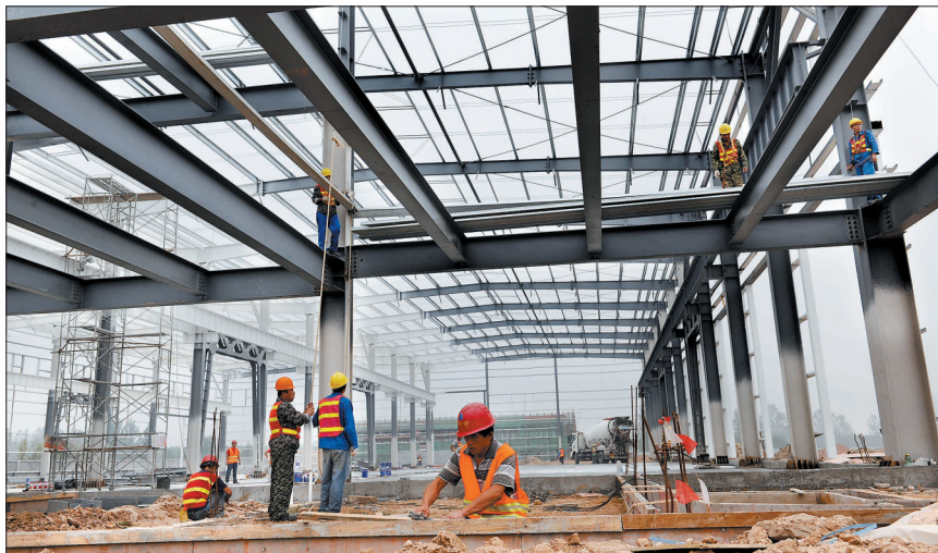
山特维克项目加紧施工
