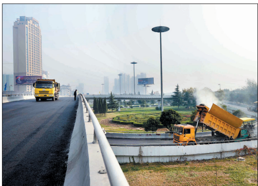
定鼎立交沥青摊铺完毕
