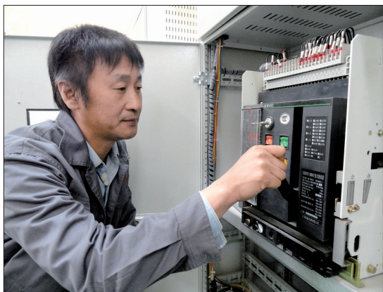
潘海洲正在调试设备
