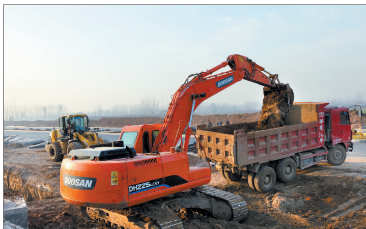
▲关林大道西延线(伊尹大道—淮南路)工程,目前主车道已竣工通车,正在进行配套管线施工,预计年底前可完工
