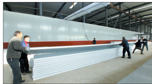
▲洛阳鹏起实业新材料研发孵化产业基地项目,钢结构车间、车间办公室装修工作基本完工
