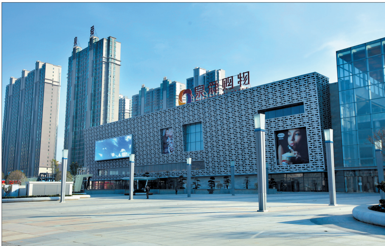
▲泉舜购物中心室内装修工作基本结束,目前进驻商户正在进行室内装修,预计在春节前开业
