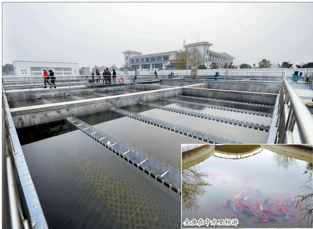
升级改造后的涧西污水处理厂高效沉淀池 记者 梅占国 摄
