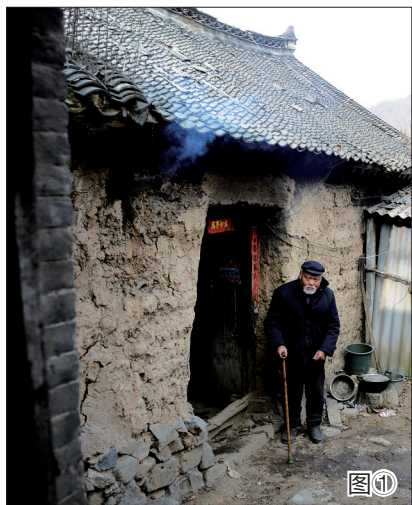
图① 椒沟村地处贫困山区,不少人还居住在土坯房内
