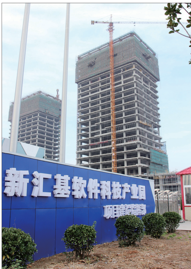
新汇基软件科技产业园项目建设指挥部
