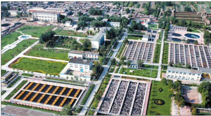
兰州石化建设污水处理设施,发展循环经济 (资料图片)
