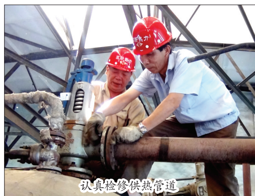
认真检修供热管道
