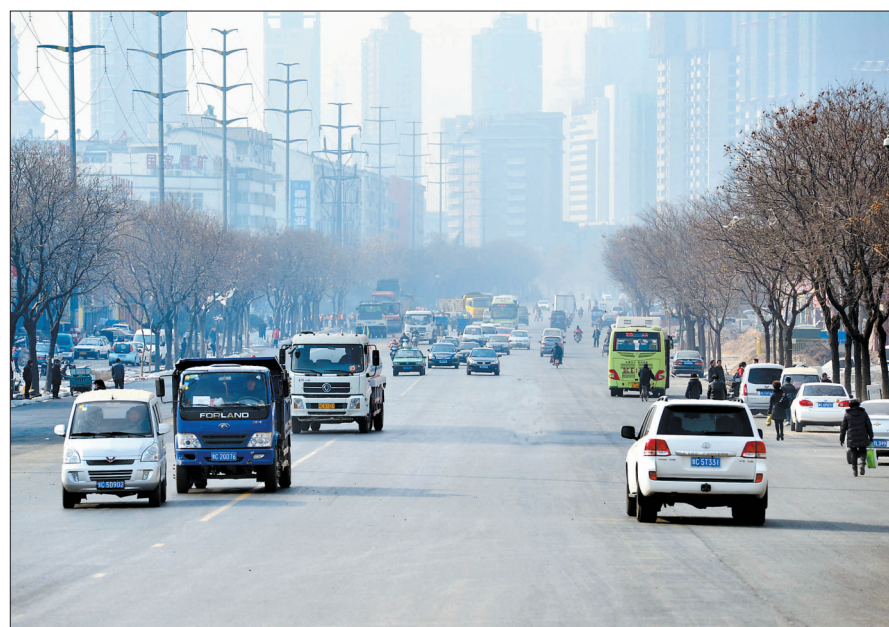
改造后的九都路 记者 梅占国 摄
