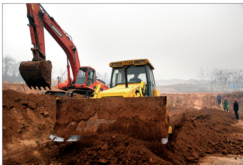
310国道新安段改建工程施工现场
