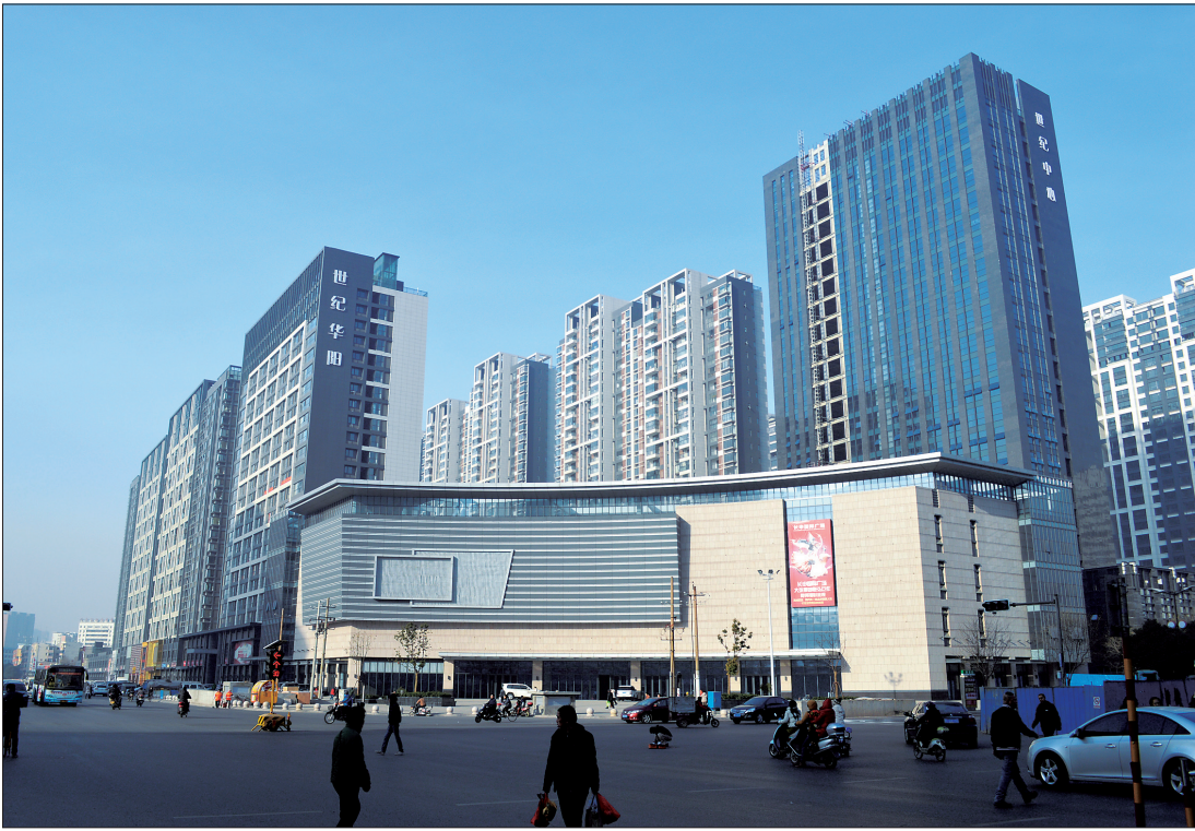
华阳商业综合体
