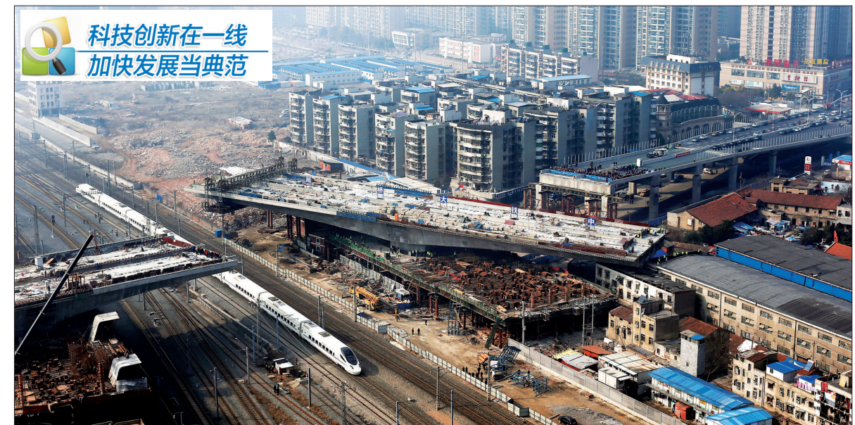
1月14日,湖北武汉姑嫂树跨铁路立交桥箱梁在进行高空转体(新华社发)
