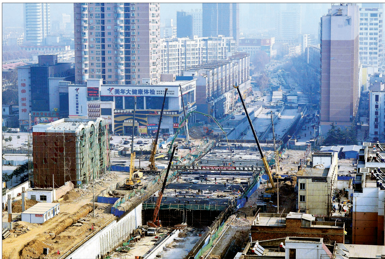
九都路下穿解放路立交工程主体结构封顶 记者 李卫超 摄
