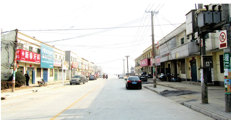
投资4759万元完成了梁新路(送庄至新庄)段改造提升工程
