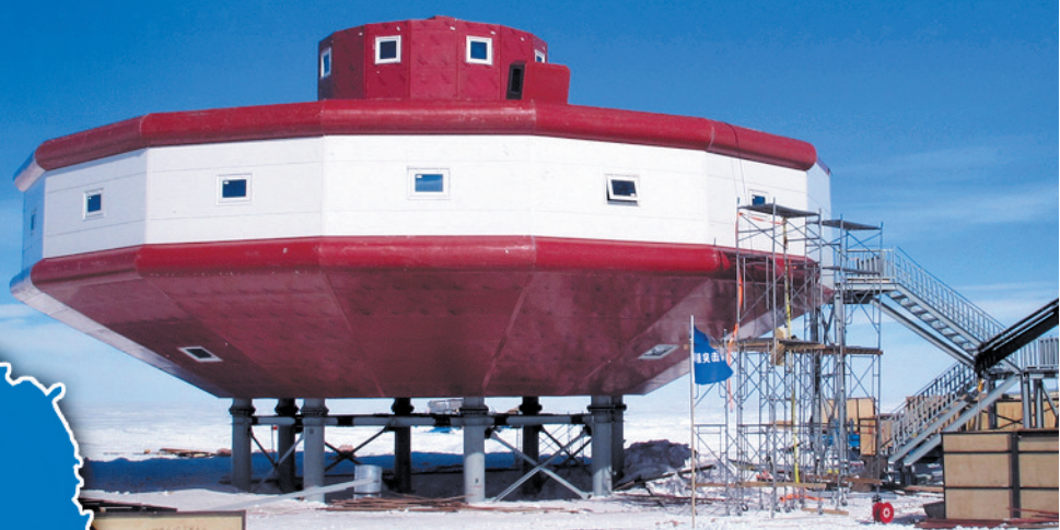
1月24日拍摄的正在建设中的泰山站主体建筑(新华社发)
